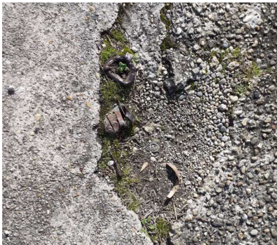
Photo 3 : traces de tubes sectionnés
